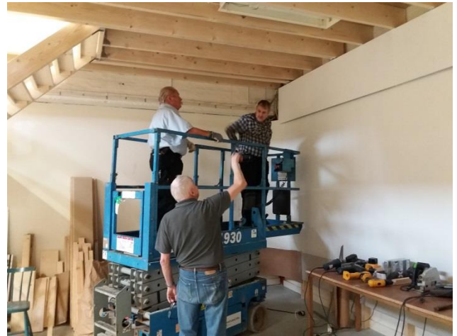
Dags för montering av lysrören över anläggningen. Arne A anvisar. Henning H och Kjell P monterar.
