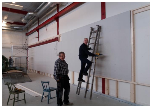
Kjell P och Anders O monterar gips på fondväggen.
