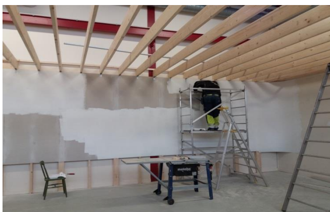
Dags för grundmålning av väggen.
