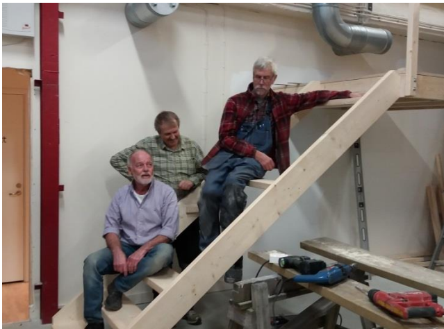
Paus i trappbygget. Lennart J, Kjell P och byggmästaren själv Ralph M begrundar bygget.
