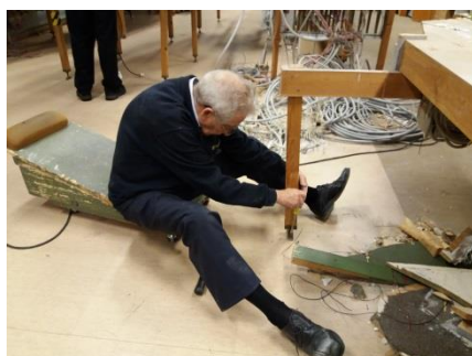
Alla 150 benen var skruvade med 2 skruv i golvet
